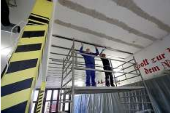
Auszubildender Christoph Hortmann-Scholten (links) und Thomas Gufler verstärken die Decke des Feuerwehrhauses mit schmalen Streifen aus Carbonit. Bild: köhler
